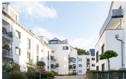
Wohnanlage in Schwabach
